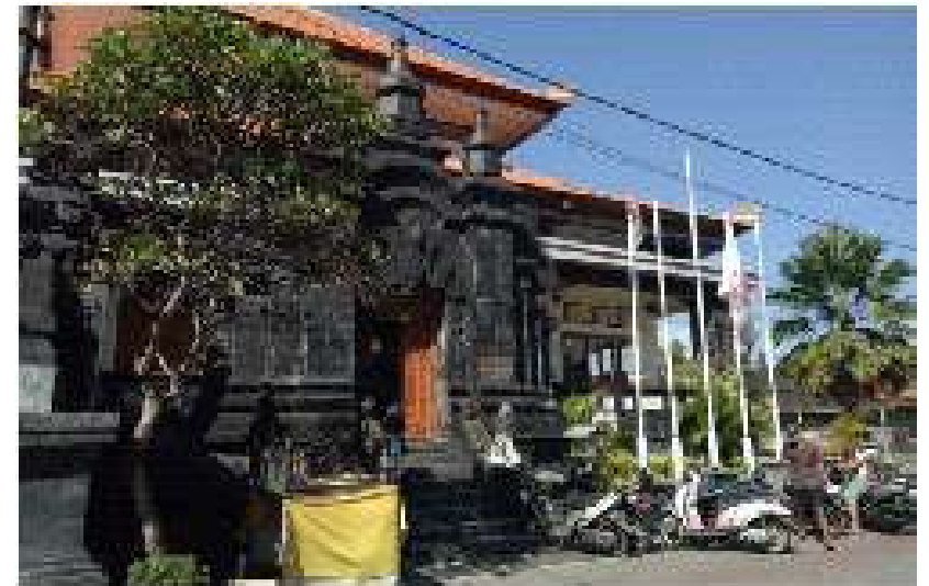
Bangunan Kantor Kelurahan dan Wantilan (balai desa)Tanjung Benoa tampak mencerminkan kearifan lokal ditata asri dan nyaman (Dok: Sumadi,2018)
