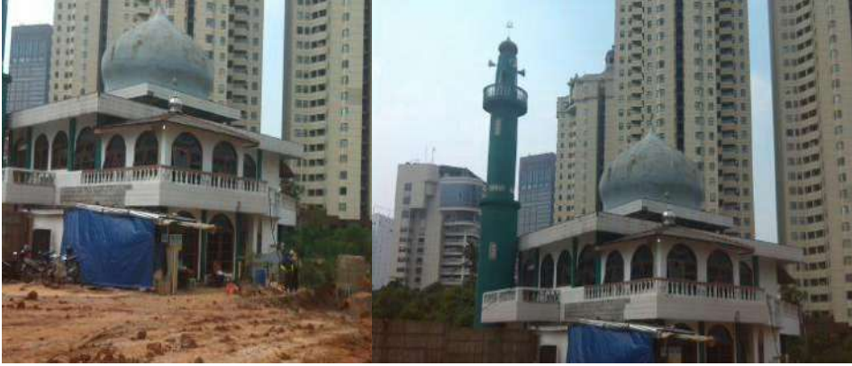
Gambar 1: Masjid Baitul Mukhlisin, tinggal sendiri ditengah banyak gedung perhotelan
